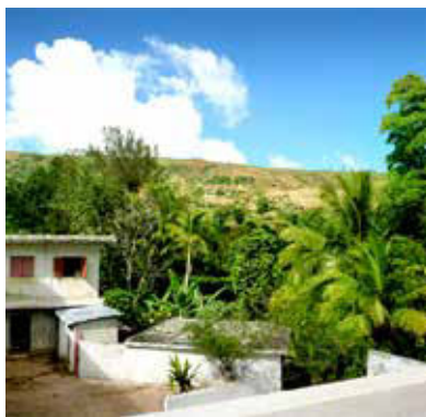
Section de l'orphelinat avant le tremblement de terre de 2010.
